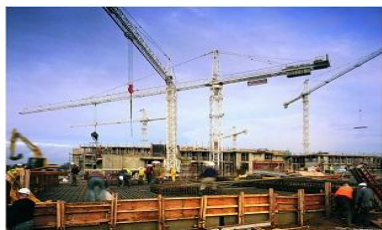
工程建设Construction
