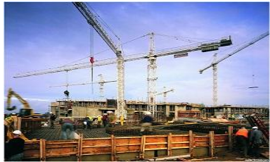
工程建设Construction
